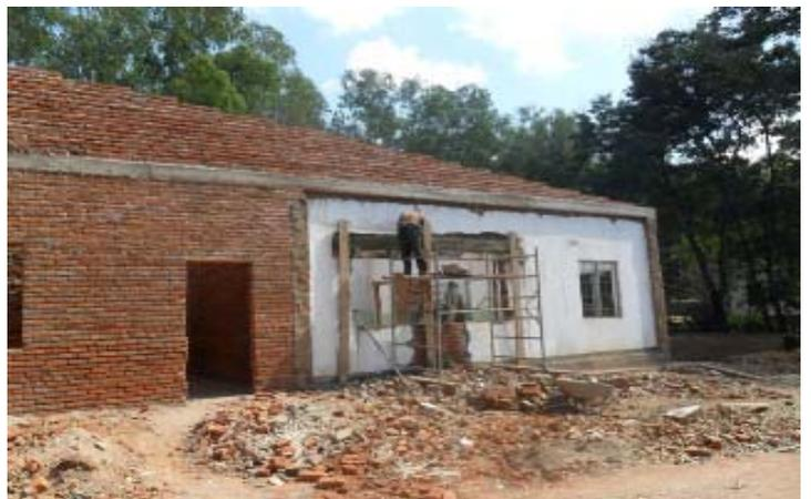
Metà del fabbricato è già stato coperto. Tutta l'intelaiatura del tetto è stata fatta in ferro per scongiurare in partenza le termite che mangiano anche le travi in legno stagionato. La capriata centrale è stata collegata su tutti i lati fino a permettere di stendere sopra le lamiere di copertura.
